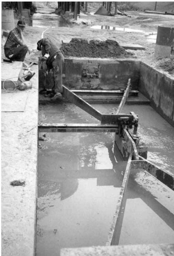
Verschmutzte Waagengrube mit Hebelwerk, ausgebaute Waagenbrücke im Hintergrund
