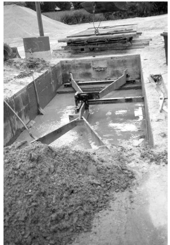
Verschmutzte Waagengrube mit Hebelwerk, ausgebaute Waagenbrücke im Hintergrund
